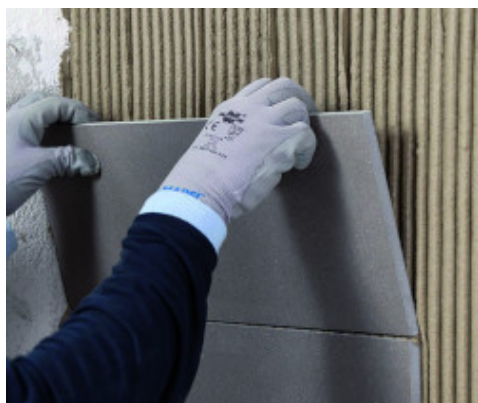
Instalación de porcellanato en paredes verticales.
