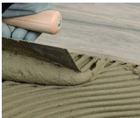
Instalación de porcellanato "imitación madera" en el suelo
