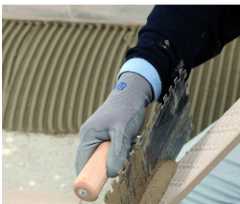
Doble extensión del adhesivo según norma UNI 11493
